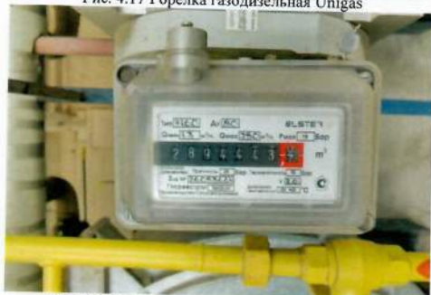
Рис. 4.19 Прибор учета расхода газа котла № 1
