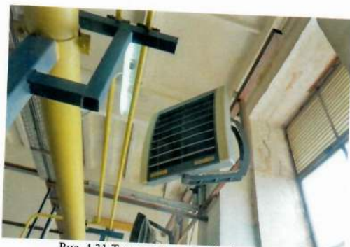
Рис. 4.31 Тепловентилятор Voolcano VR1
