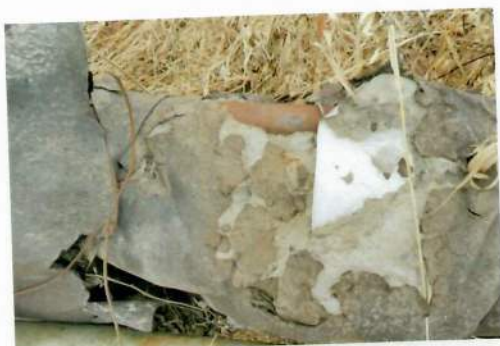
Рис. 4.133 Разрушение теплоизоляции
