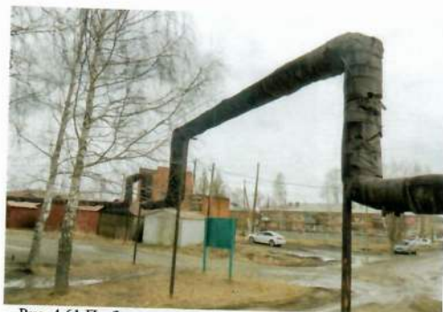
Рис. 4.61 П-образные переходы магистрали теплосети над проезжей частью
