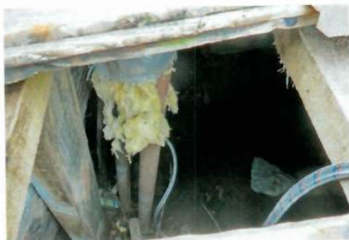
Рис. 4.101 Колодец магистральный тепловой сети
