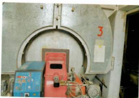
Рис. 4.17 Горелка газодизельная Unigas
