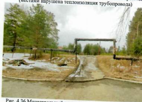
Рис. 4.36 Магистральный компенсатор системы отопления
