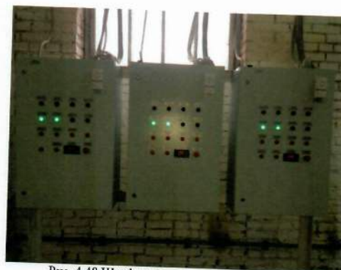
Рис. 4.48 Шкаф управления котлами (3шт)
