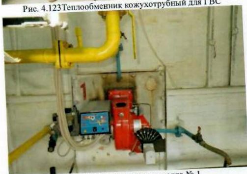
Рис. 4.125 Газовая горелка котла № 1
