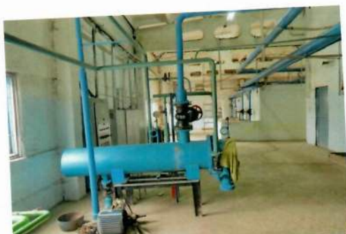
Рис. 4.123 Теплообменник кожухотрубный для ГВС
