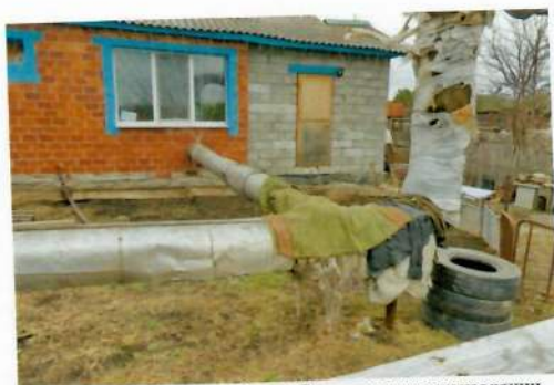
Рис. 4.137 Ввод в жилой дом. Разрушение теплоизоляции
