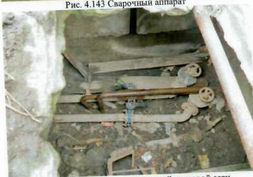
Рис. 4.145 Колодец магистральный тепловой сети
