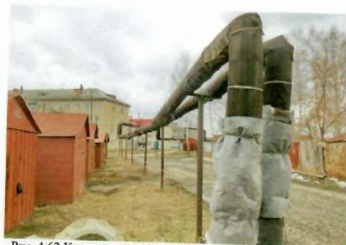
Рис. 4.62 Колодец магистральный тепловой сети Т1иТ2
