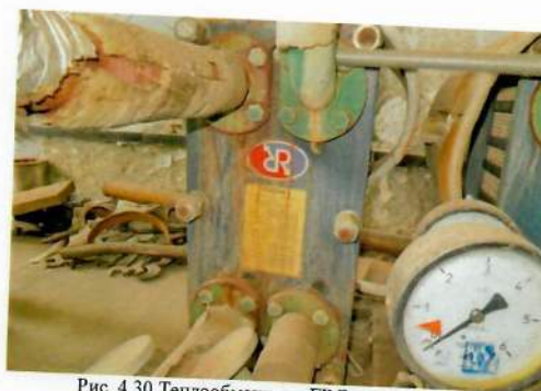
Рис. 4.30 Теплообменники ГВС пластинчатые
