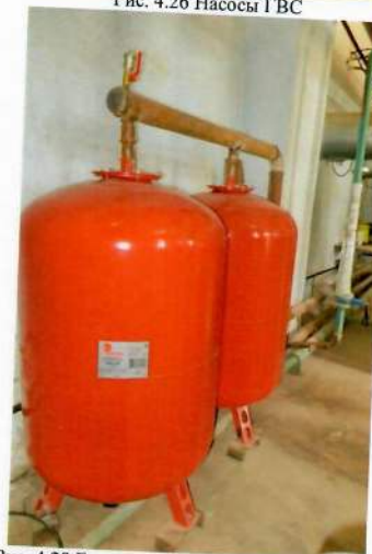
Рис. 4.28 Баки мембранные расширительные
