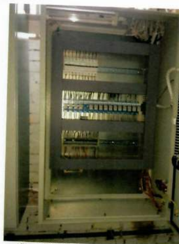
Рис. 4.42 Шкаф управления Котлом
