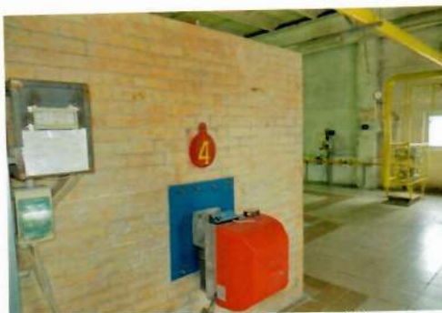
Рис. 4.86 Горелка дизельная котла №4
