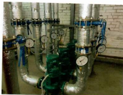
Рис. 4.54 Насосы рециркуляции
