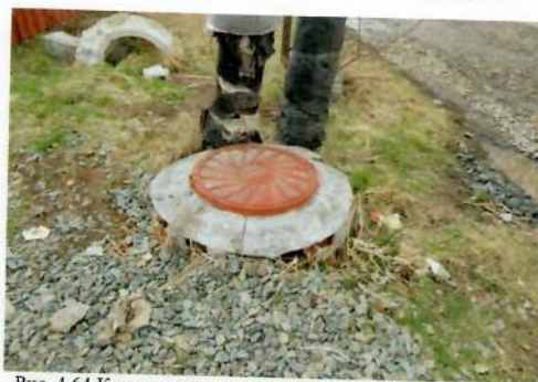
Рис. 4.64 Колодец магистральный тепловой сети Т1иТ2
