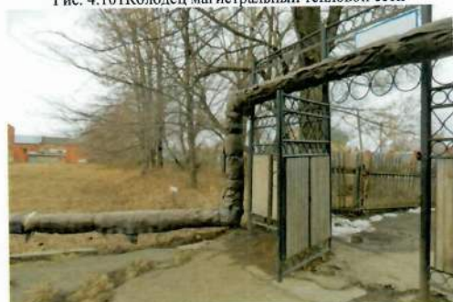
Рис. 4.103 Надземный переход теплотрассы над проездом
