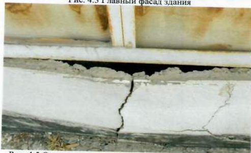
Рис. 4.5 Отслоение внешней части стены оконного проема
