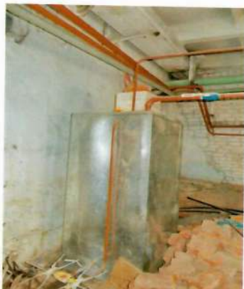
Рис. 4.23 Ёмкость под дизтопливо (не используется)
