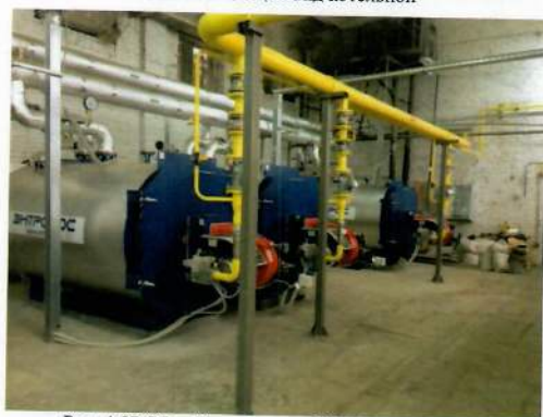
Рис. 4.57 Общий вид котлов (КВ-ГМ-3-115 -3шт)
