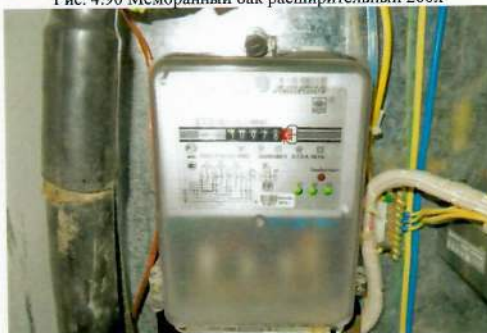
Рис. 4.92 Прибор учета электроэнергии
