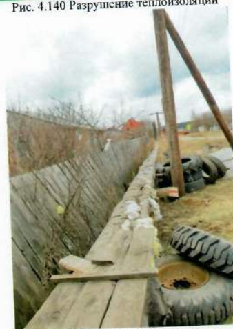
Рис. 4.142 Разрушение теплоизоляции
