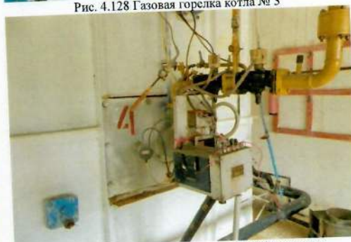
Рис. 4.130 Газовая горелка котла № 4 (двигатель демонтирован)
