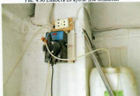
Рис. 4.98 Дозатор хим.водоподготовки с канистрой реагентов СК-110
