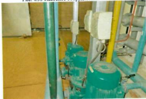
Рис. 4.95 Сетевые насосы
