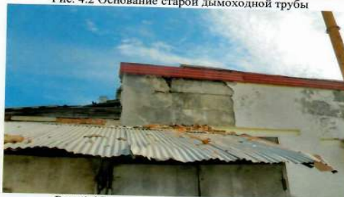
Рис. 4.4 Разрушение внешней стены здания
