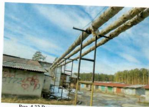
Рис. 4.32 Ввод теплотрассы в здание котельной
