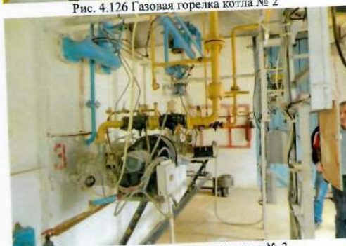
Рис. 4.128 Газовая горелка котла № 3
