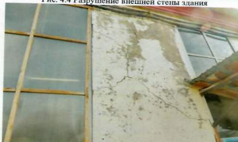
Рис. 4.6 Трещины по стене главного фасада
