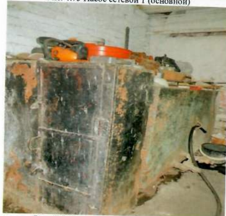
Рис. 4.77 Емкость стальная для подпитки
