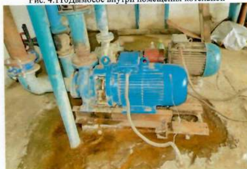
Рис. 4.112 Насосы сетевые
