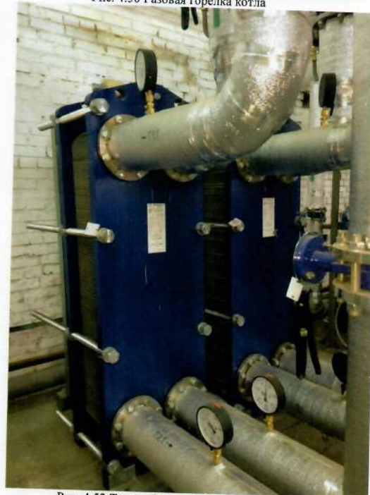
Рис. 4.52 Теплообменное оборудование
