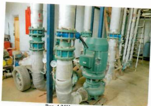
Рис. 4.25 Насосы сетевые
