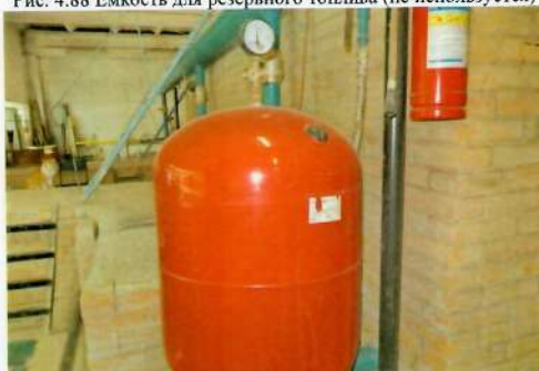
Рис. 4.90 Мембранный бак расширительный 200л
