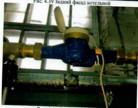
Рис. 4.41 Счетчик подпитки
