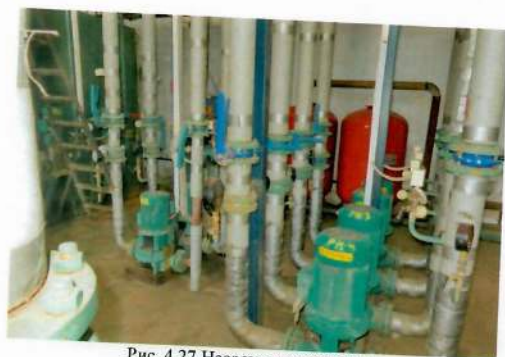
Рис. 4.27 Насосы рециркуляции
