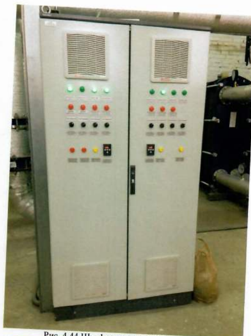
Рис. 4.44 Шкаф управления насосами
