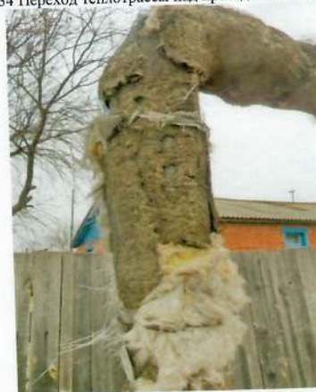
Рис. 4.136 Разрушение теплоизоляции
