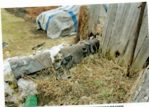
Рис. 4.140 Разрушение теплоизоляции
