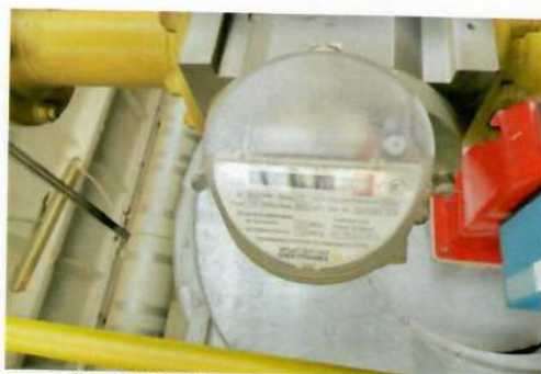
Рис. 4.21 Прибор учета расхода газа котла № 3
