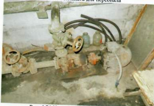
Рис. 4.76 Насос сетевой 2 (неисправен)
