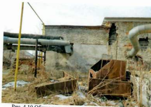
Рис. 4.10 Общее разрушение внешней несущей стены
