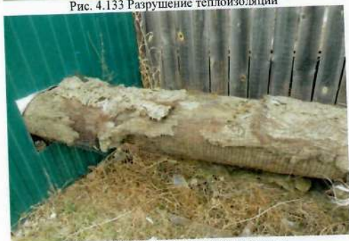
Рис. 4.135 Разрушение теплоизоляции
