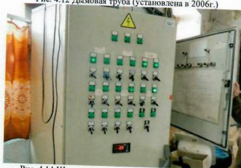
Рис. 4.14 Щит управления насосами и вентиляторами
