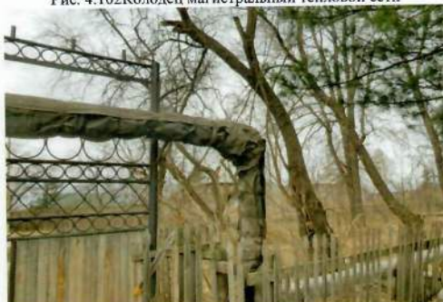
Рис. 4.104 Надземный переход теплотрассы над проездом
