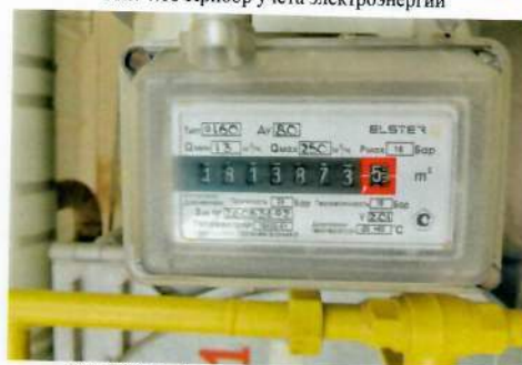
Рис. 4.20 Прибор учета расхода газа котла № 2
