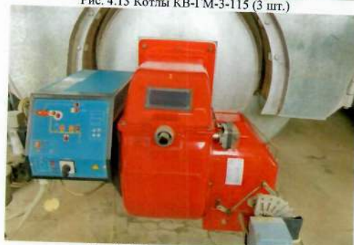
Рис. 4.15 Горелка газовая Unigas
