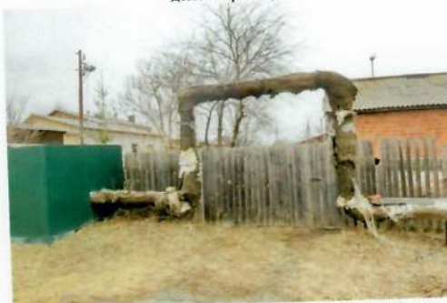
Рис. 4.134 Переход теплотрассы над проездом к жилому дому
