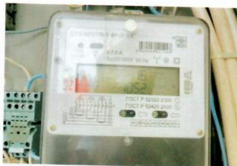
Рис. 4.18 Прибор учета электроэнергии
