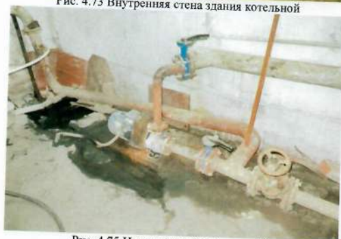
Рис. 4.75 Насос сетевой 1 (основной)
