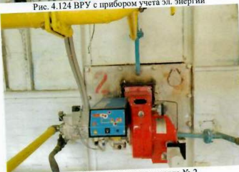
Рис. 4.126 Газовая горелка котла № 2
