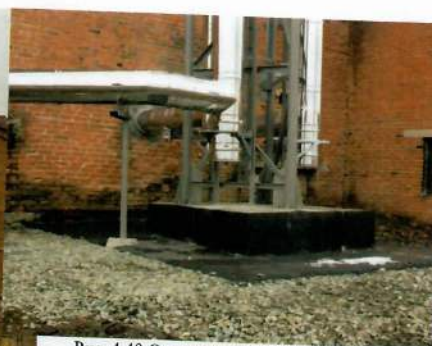
Рис. 4.40 Основание дымовой трубы
