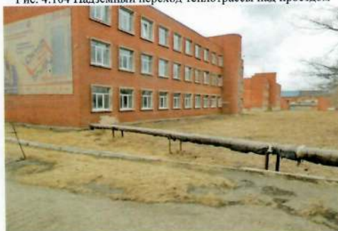
Рис. 4.106 Надземная теплотрасса. Ввод в здание училища
