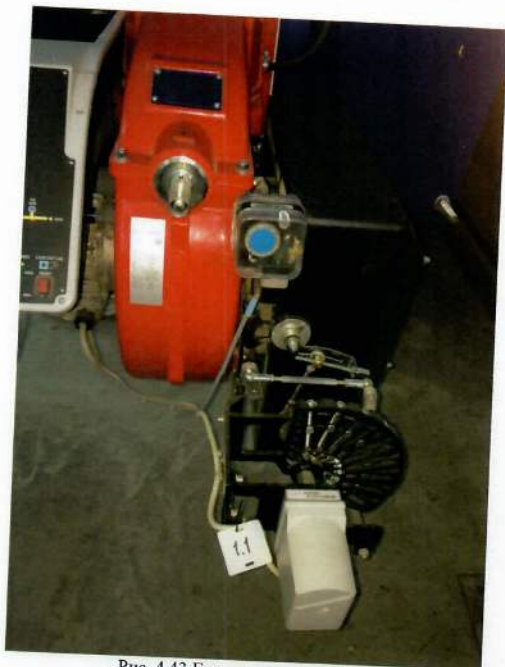
Рис. 4.43 Газовая горелка Котла
