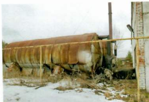
Рис. 4.108 Цистерны для воды 2x50 куб.м. (не используются)
