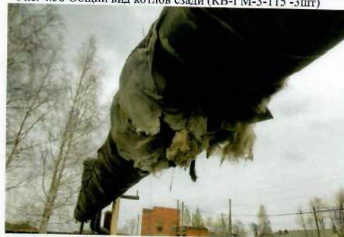
Рис. 4.60 Частичное разрушение теплоизоляции
