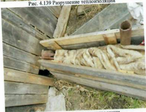
Рис. 4.141 Разрушение теплоизоляции
