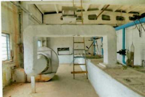
Рис. 4.110 Дымосос внутри помещения котельной
