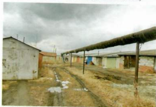
Рис. 4.59 Надземный участок магистральной теплосети
