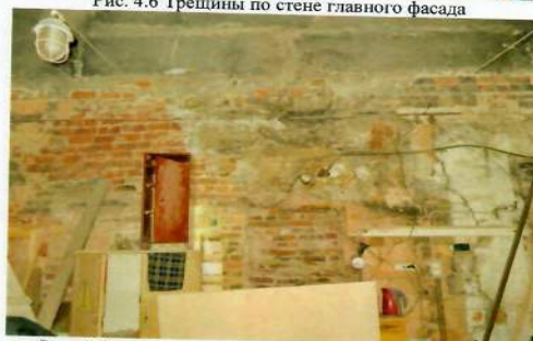
Рис. 4.8 Разрушение кирпичной кладки несущей стены
