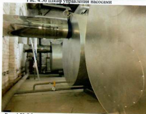
Рис. 4.58 Общий вид котлов сзади (КВ-ГМ-3-115 -3шт)
