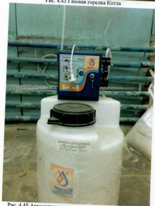
Рис. 4.45 Автоматическая система дозирования реагентов
