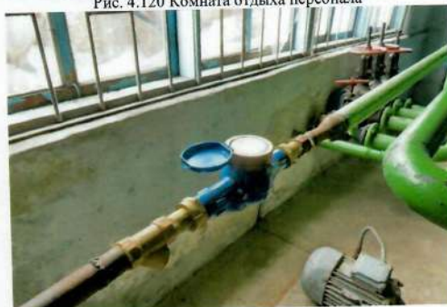
Рис. 4.122 Счетчик воды
