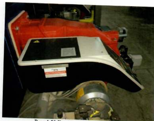
Рис. 4.50 Газовая горелка котла
