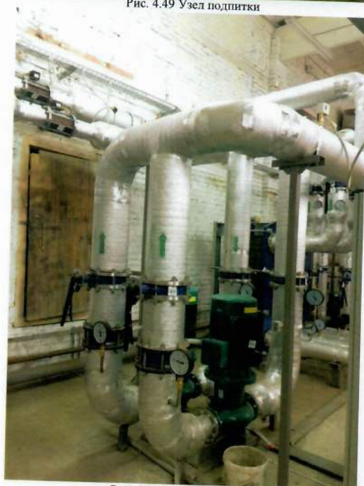
Рис. 4.51 Сетевые насосы
