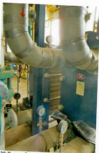
Рис. 4.29 Теплообменники отопления пластинчатые
