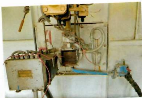
Рис. 4.132 Газовая горелка котла № 4 (двигатель демонтирован)
