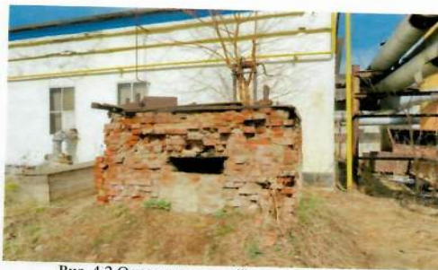
Рис. 4.2 Основание старой дымоходной трубы
