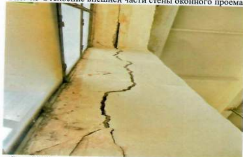
Рис. 4.7 Трещины по несущей стене внутри помещения
