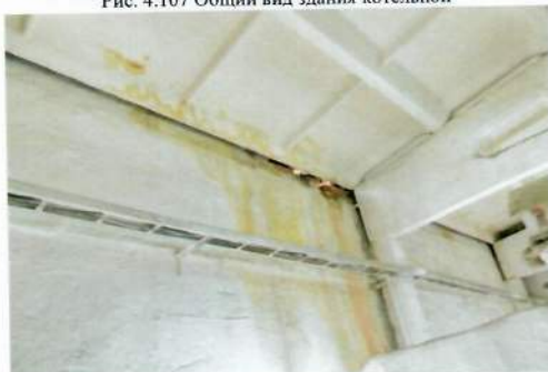
Рис. 4.109 Следы протекания кровли
