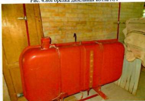
Рис. 4.88 Емкость для резервного топлива (не используется)
